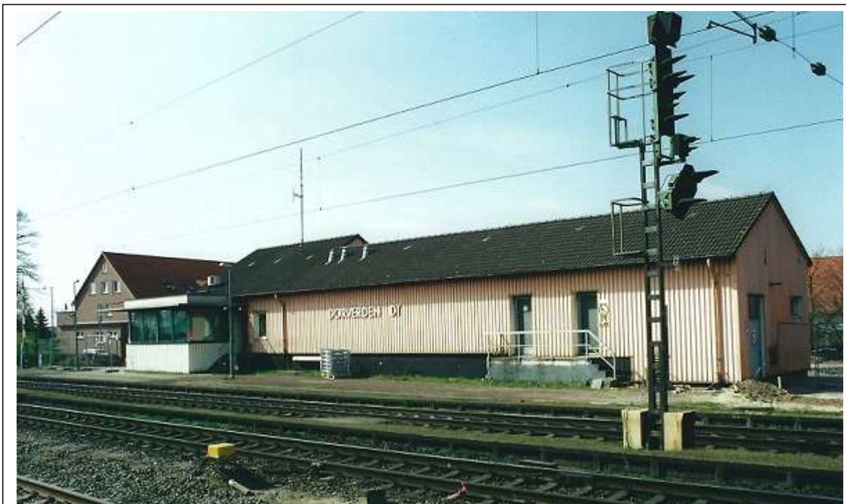
Bahnhofsgebäude Dörverden 2000, Fotoarchiv Ehmken Hoff e.V.
