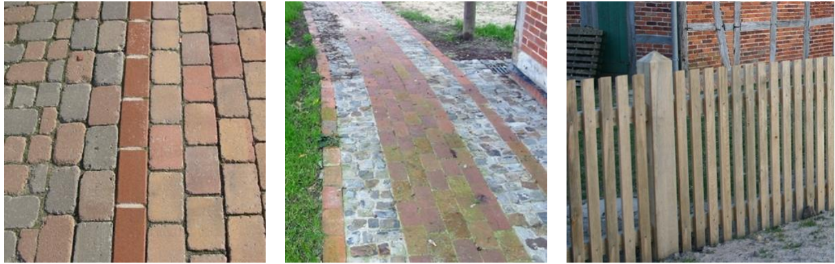
Abb. 58 Beispiele: gerumpeltes Betonrechteckpflaster, Naturstein/Klinker, Holz-Staketenzaun
