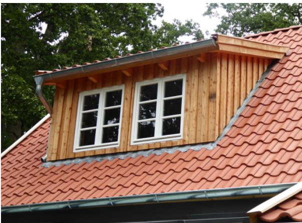
Abb. 56 Beispiele: Neue Dachgaube mit Fenstern und Holzverschalung, erneuerte Fachwerkfassade
