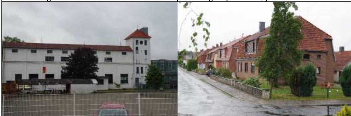
Hülsen NORKA, alte Kali-Gebäude
