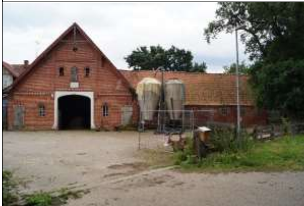
Alte Hoflage mit Sanierungsbedarf
